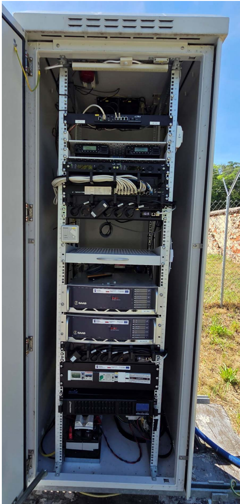
Rysunek 11: Szafa teletechniczna typu outdoor w lokalizacji Gozdowice
