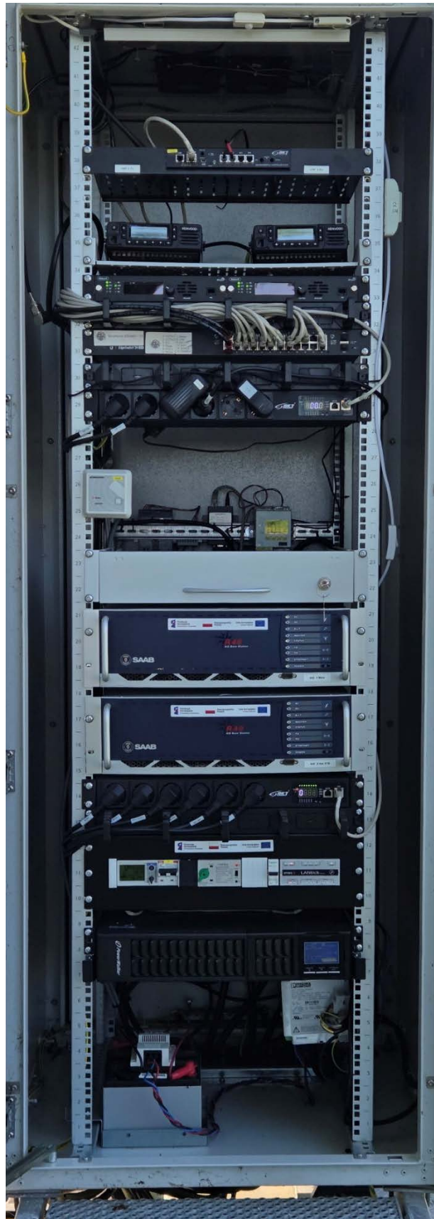
Rysunek 13: Szafa teletechniczna typu outdoor w lokalizacji Świerkocin
