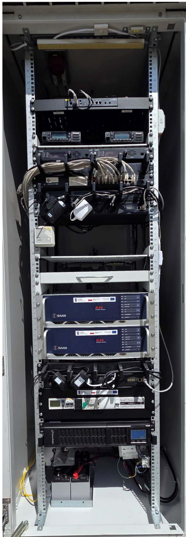
Rysunek 9: Szafa teletechniczna typu outdoor w lokalizacji Bielinek
