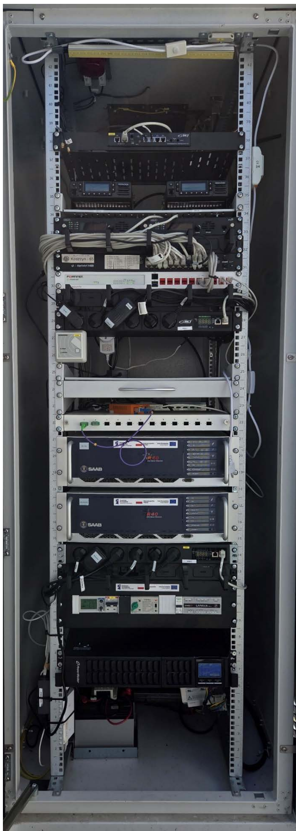
Rysunek 15: Szafa teletechniczna typu outdoor w lokalizacji Kostrzyn nad Odrą
