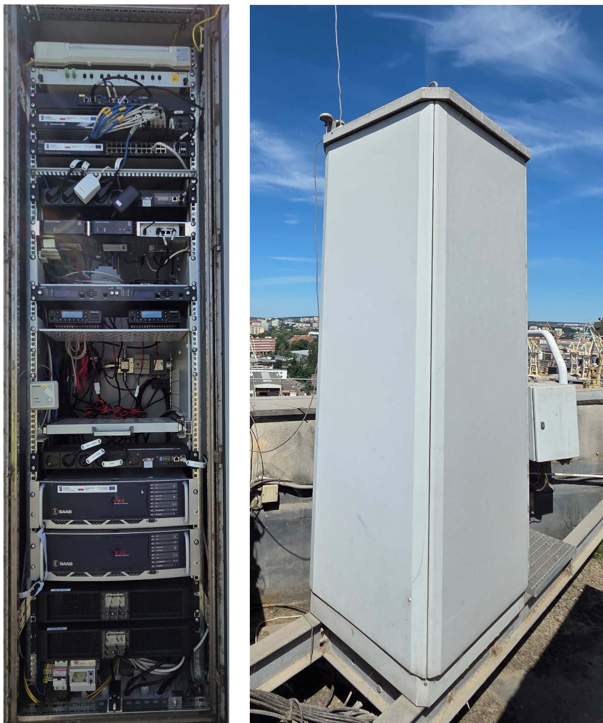
Rysunek 2: Szafa teletechniczna typu outdoor w lokalizacji Elewator EWA
