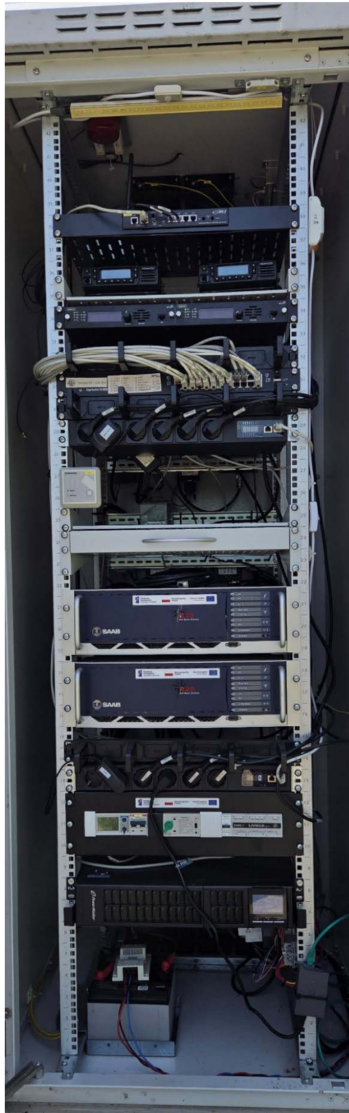
Rysunek 18: Szafa teletechniczna typu outdoor w lokalizacji Słubice
