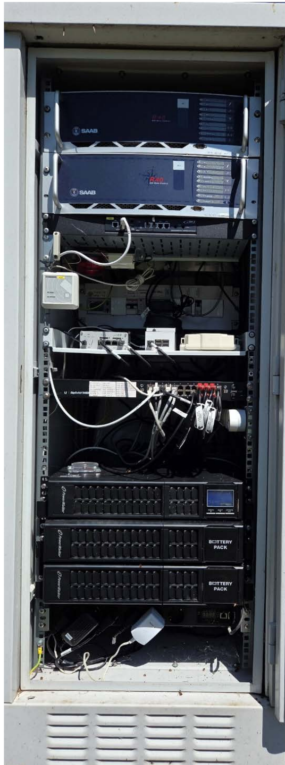
Rysunek 5: Szafa teletechniczna typu outdoor w lokalizacji Siadło Górne
