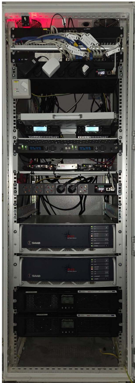
Rysunek 7: Szafa teletechniczna w lokalizacji Widuchowa
