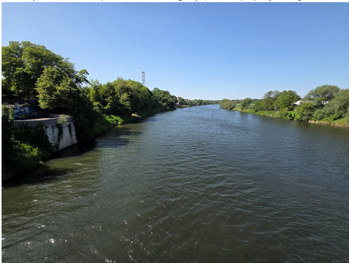
Rysunek 112: Krapkowice, Most drogowy (DW 409) – widok w kierunku północno-zachodnim
