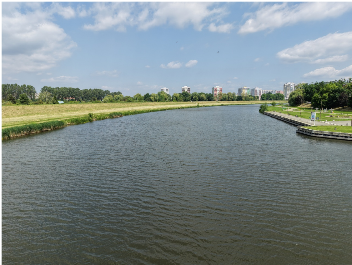
Rysunek 102: Opole, Most kolejowy (LK 132) – widok w kierunku północnym
