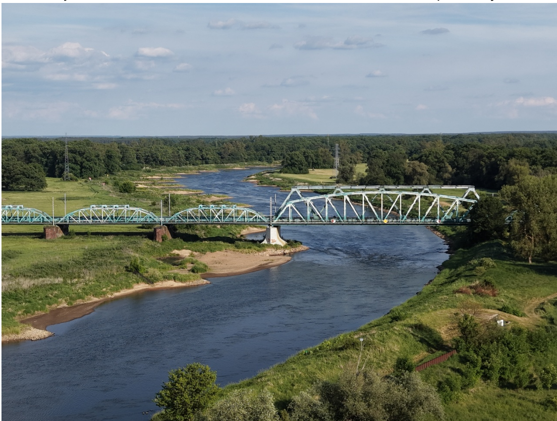
Rysunek 62: Ścinawa, wieża radiowa - widok w kierunku południowym, Mostu Kolejowego
