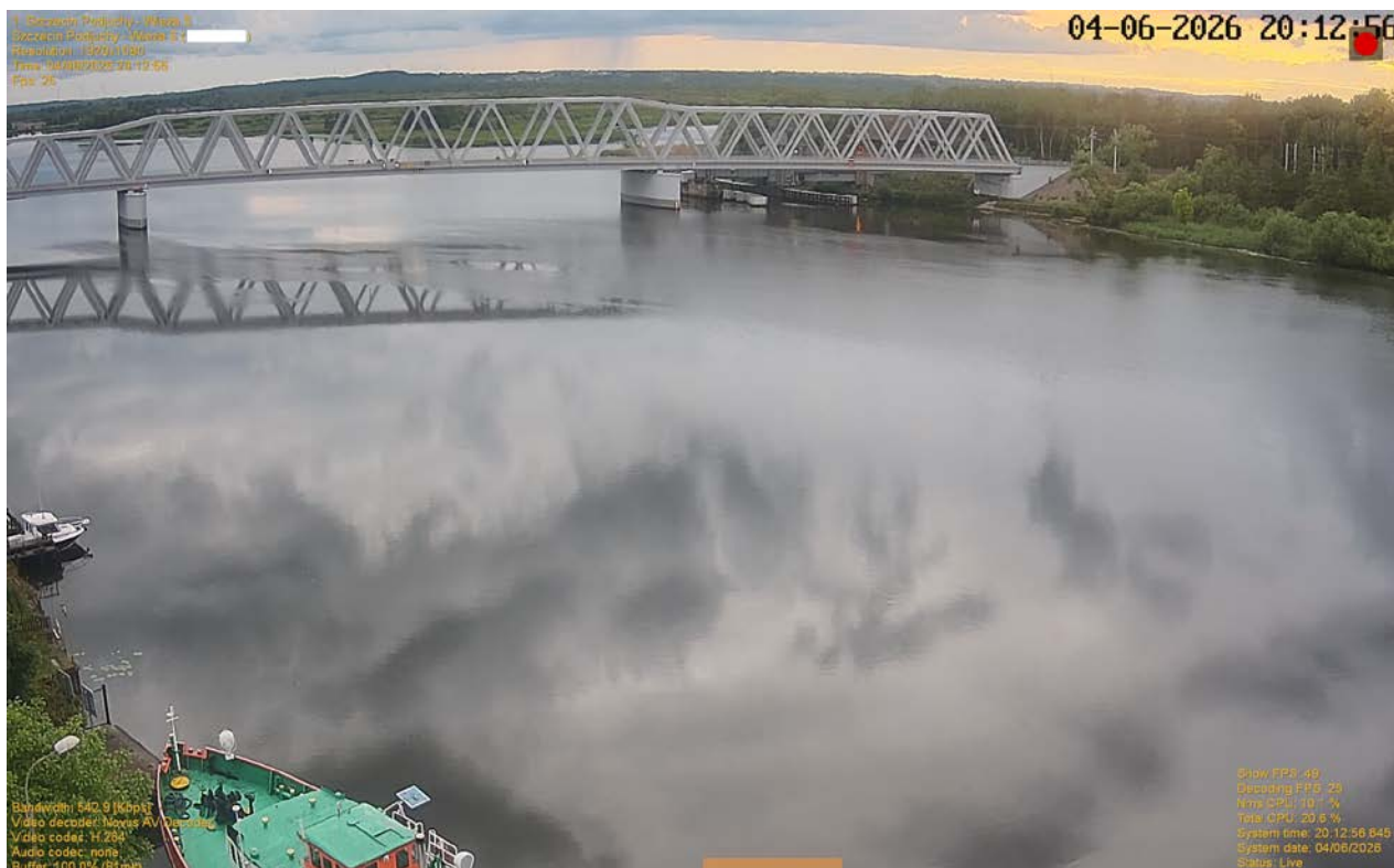
Rysunek 24: Szczecin Podjuchy – Wieża na terenie placówki RZGW, widok z kamery w kierunku zachodnim, Most kolejowy imienia dr. inż. Andrzeja Krefta
