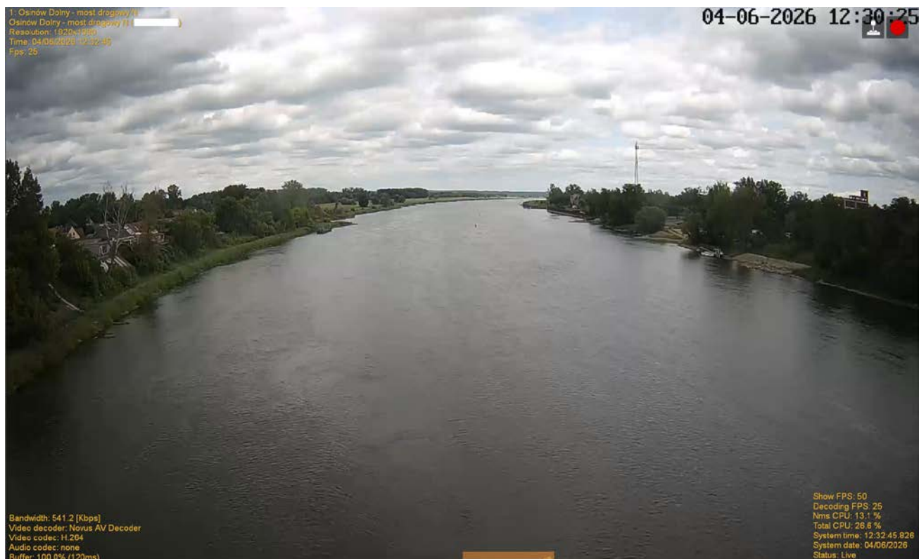
Rysunek 45: Osinów Dolny – Most drogowy na Odrze, widok z kamery w kierunku północnym
