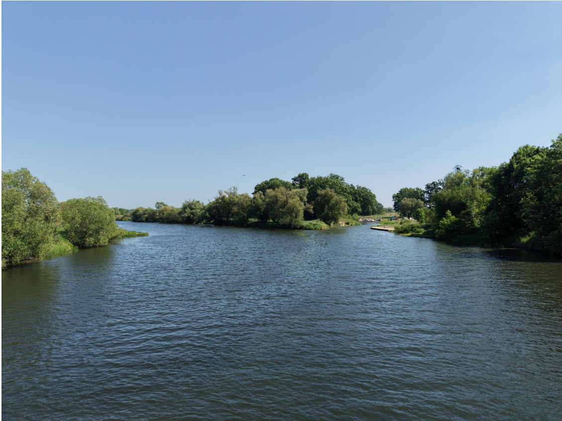
Rysunek 113: Krapkowice, Most drogowy (DW 409) – widok w kierunku południowo-wschodnim
