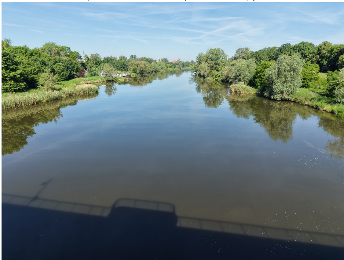
Rysunek 92: Wrocław Dąbie, Most Olimpijski – widok w kierunku zachodnim
