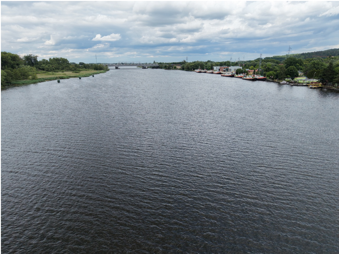
Rysunek 60: Szczecin Podjuchy, Most kolejowy im. dr inż. Andrzeja Krefta - widok w kierunku południowym
