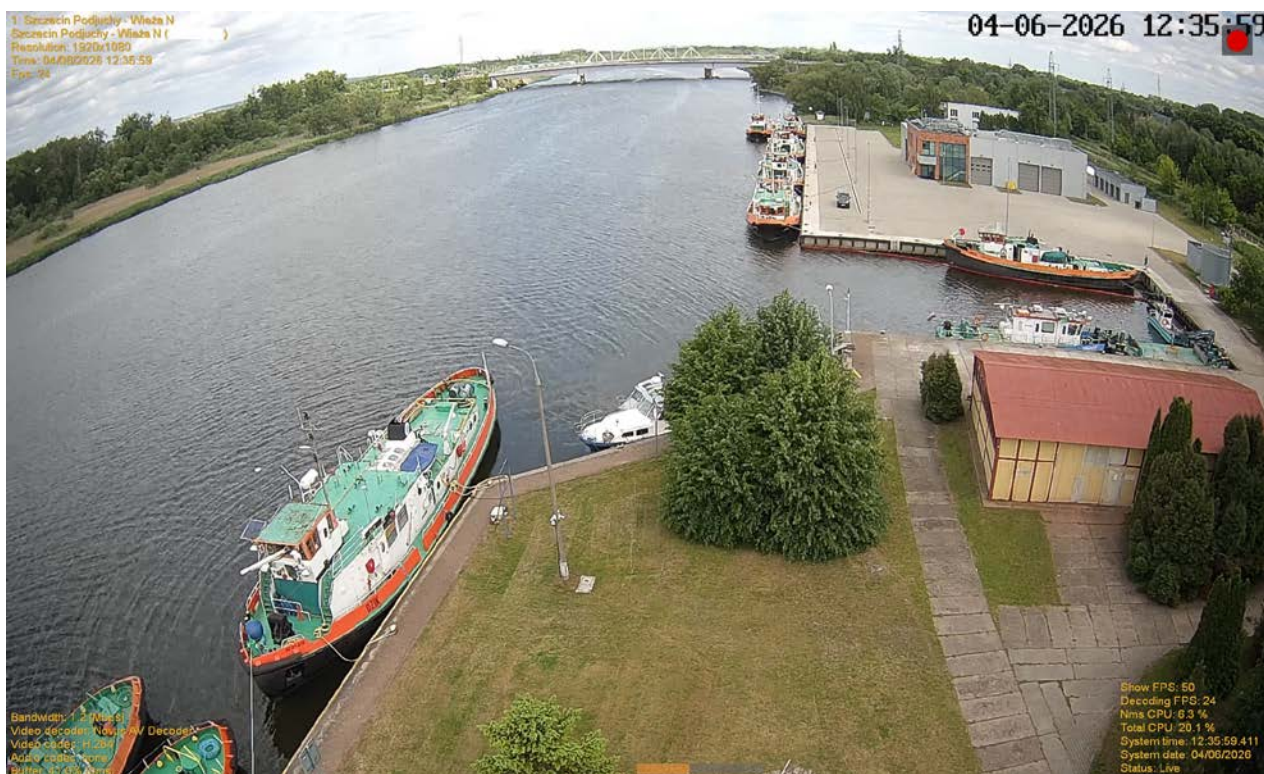
Rysunek 25: Szczecin Podjuchy – Wieża na terenie placówki RZGW, widok z kamery w kierunku północno-wschodnim, Most Gryfitów
