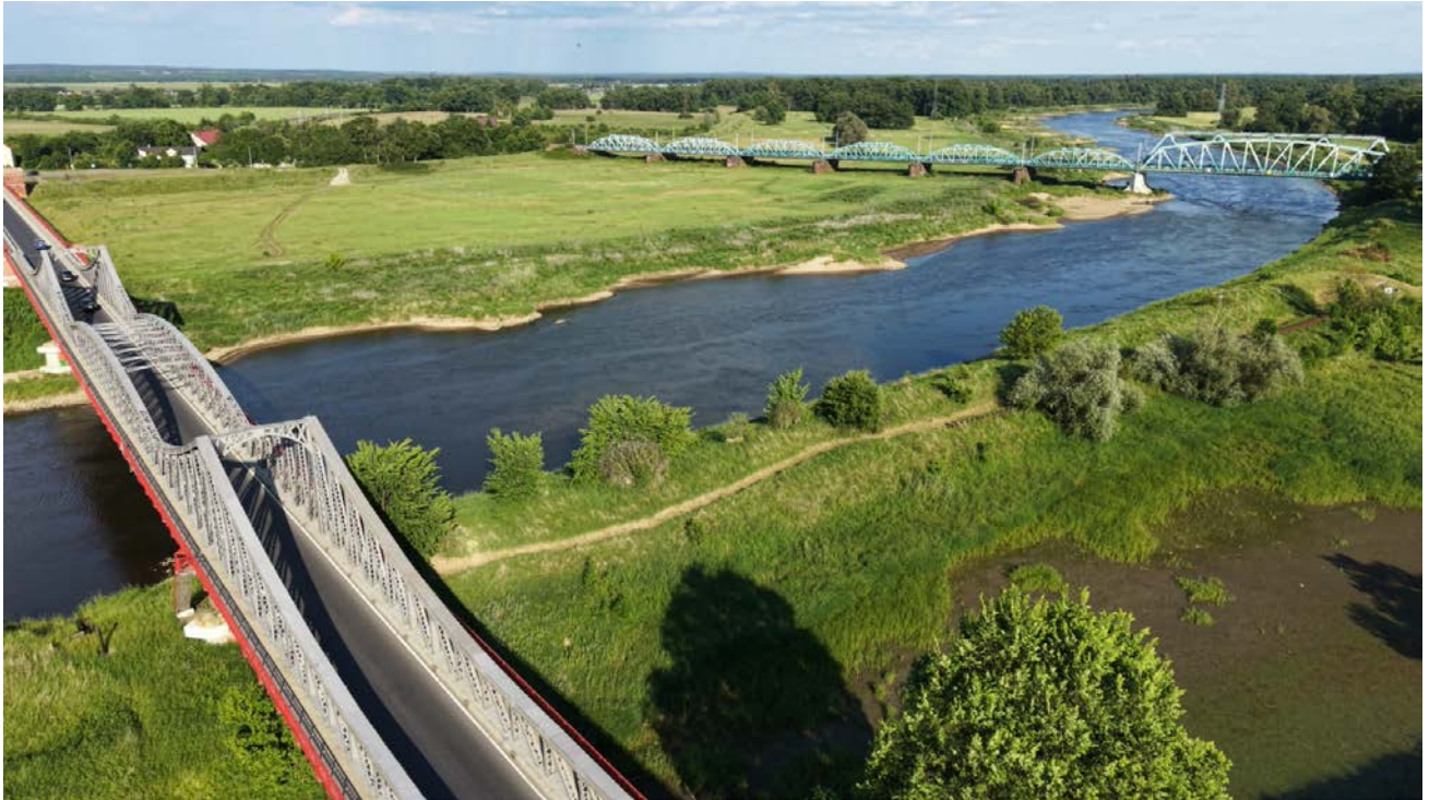
Rysunek 63: Ścinawa, wieża radiowa - widok w kierunku południowo-wschodnim
