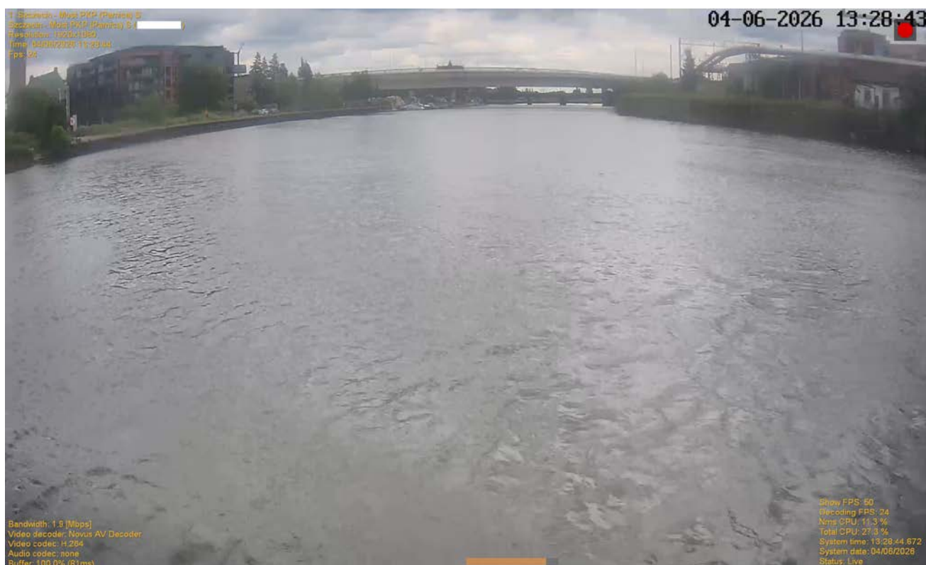
Rysunek 13: Most kolejowy Parnica, widok z kamery w kierunku południowym
