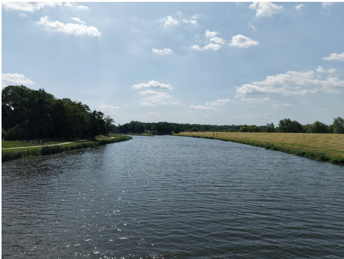
Rysunek 103: Opole, Most kolejowy (LK 132) – widok w kierunku południowym
