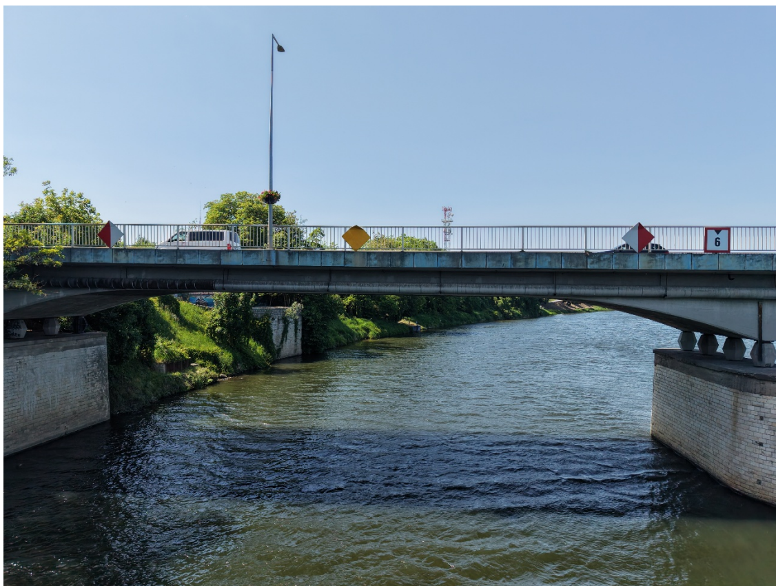
Rysunek 111: Krapkowice, Most drogowy (DW 409) – przęśło żeglowne
