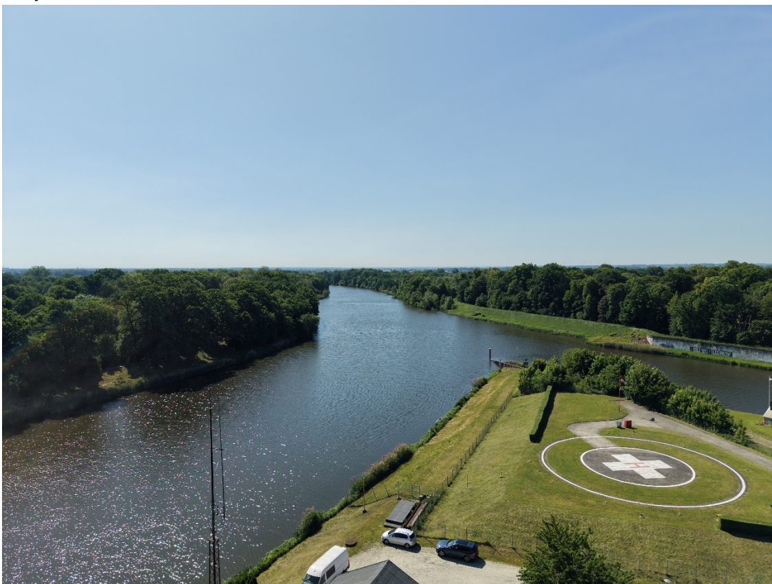
Rysunek 121: Koźle, Ostrówek baza NW RZGW – widok w kierunku południowo-wschodnim
