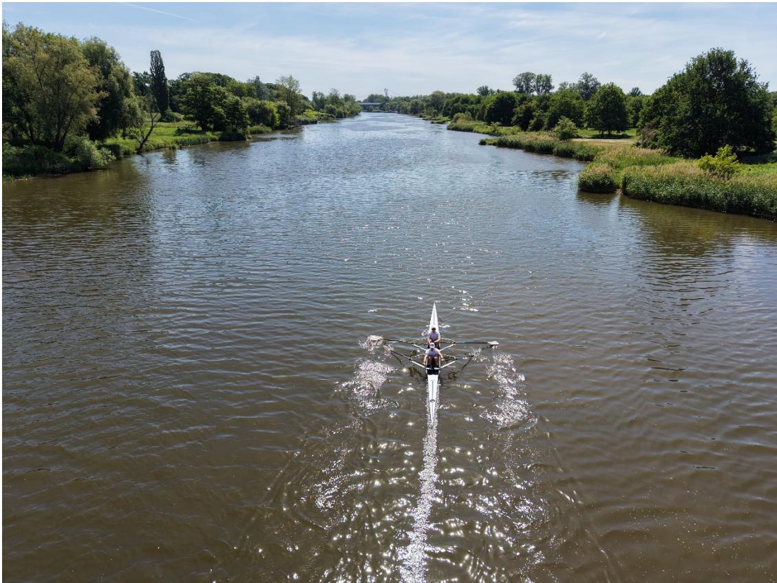
Rysunek 90: Wrocław Dąbie, Kładka Zwierzyniecka – widok w kierunku wschodnim
