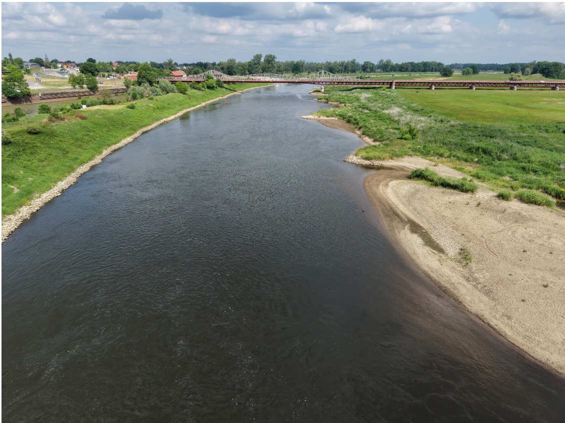
Rysunek 68: Ścinawa, Most kolejowy (LK273) - widok w kierunku północnym
