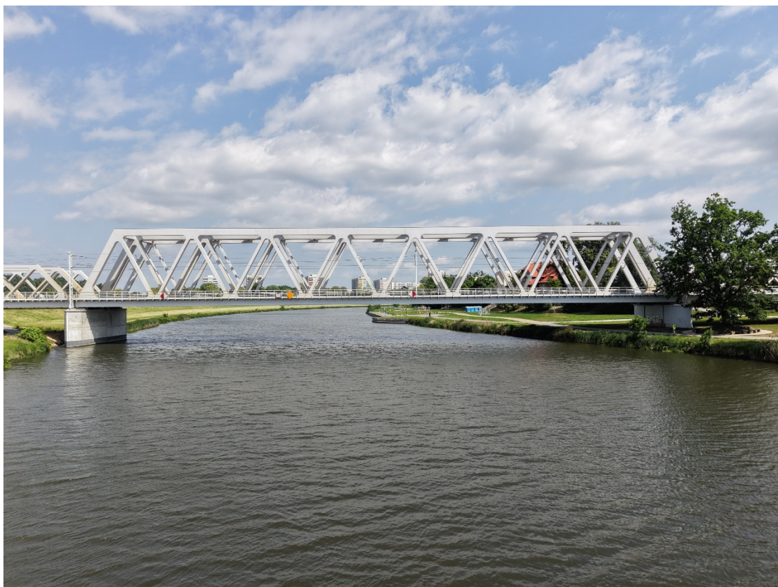
Rysunek 101: Opole, Most kolejowy (LK 132) - widok na most od strony południowej
