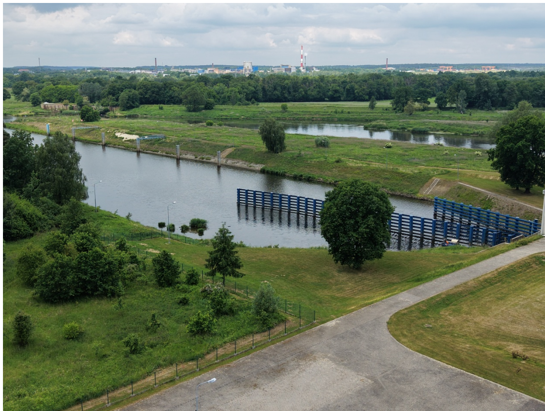
Rysunek 70: Brzeg Dolny, śluza Brzeg Dolny – widok w kierunku zachodnim
