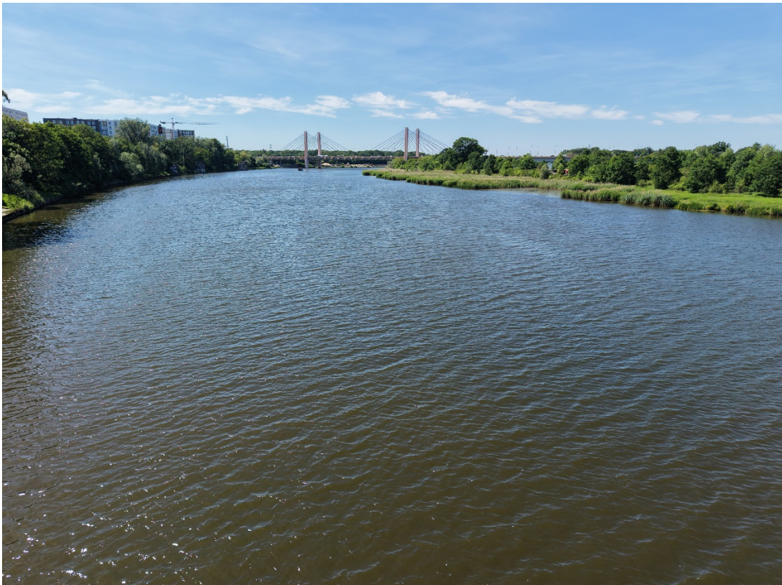
Rysunek 78: Wrocław Osobowice, Most kolejowy (LK 271) – widok w kierunku zachodnim
