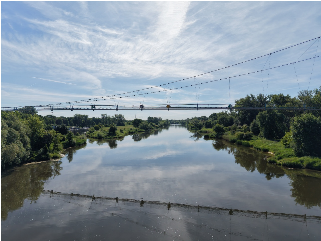
Rysunek 93: Wrocław Dąbie, Most Olimpijski – widok w kierunku wschodnim
