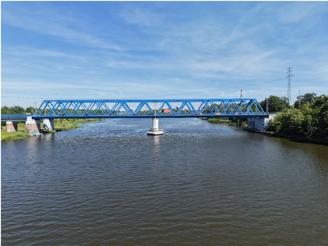
Rysunek 77: Wrocław Osobowice, Most kolejowy (LK 271)
