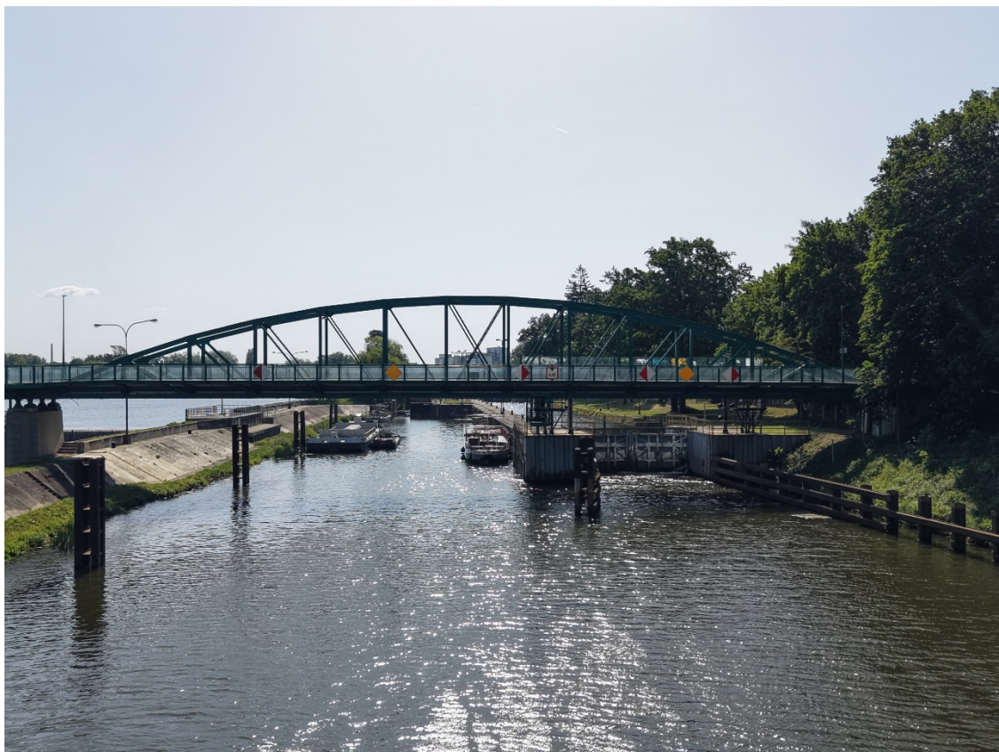
Rysunek 106: Opole, Most im. Ireny Sendlerowej (przęsło nad wejściem do śluzy)
