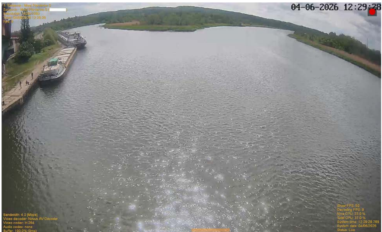
Rysunek 19: Szczecin – Most Pionierów, widok z kamery w kierunku południowym
