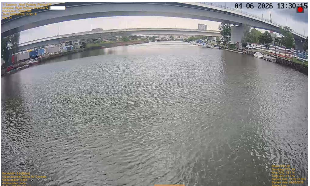
Rysunek 11: Szczecin – Most Portowy, widok z kamery w kierunku zachodnim
