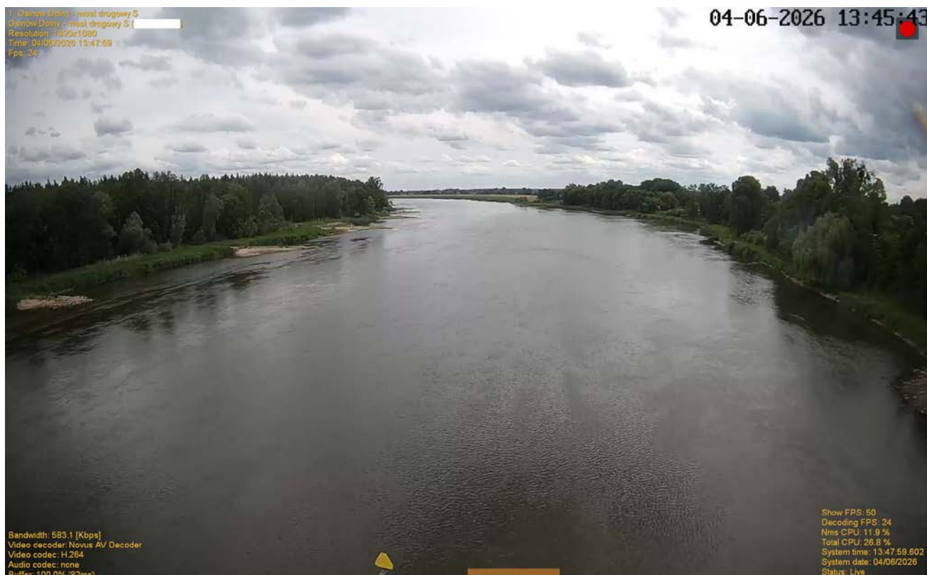
Rysunek 46: Osinów Dolny – Most drogowy na Odrze, widok z kamery w kierunku południowym
